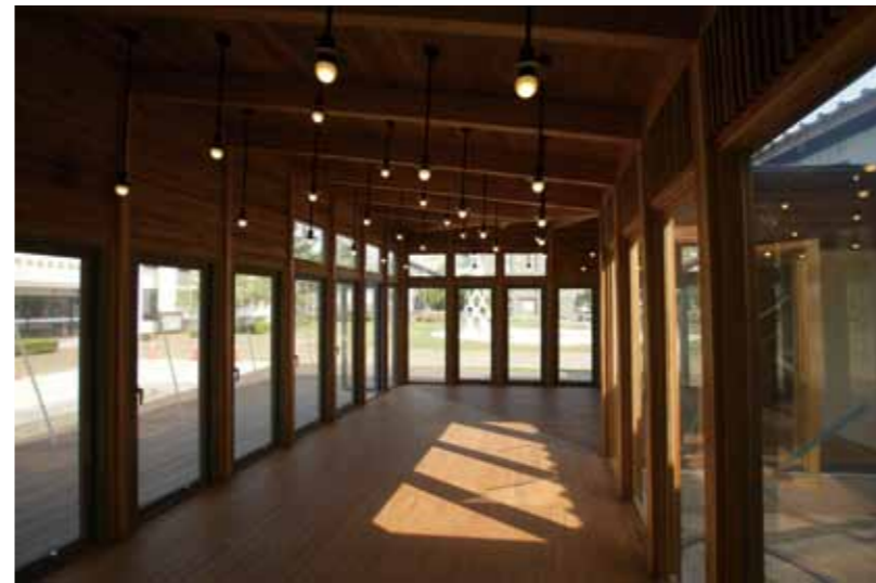
餐廳後棟以現代全木構工法施做
