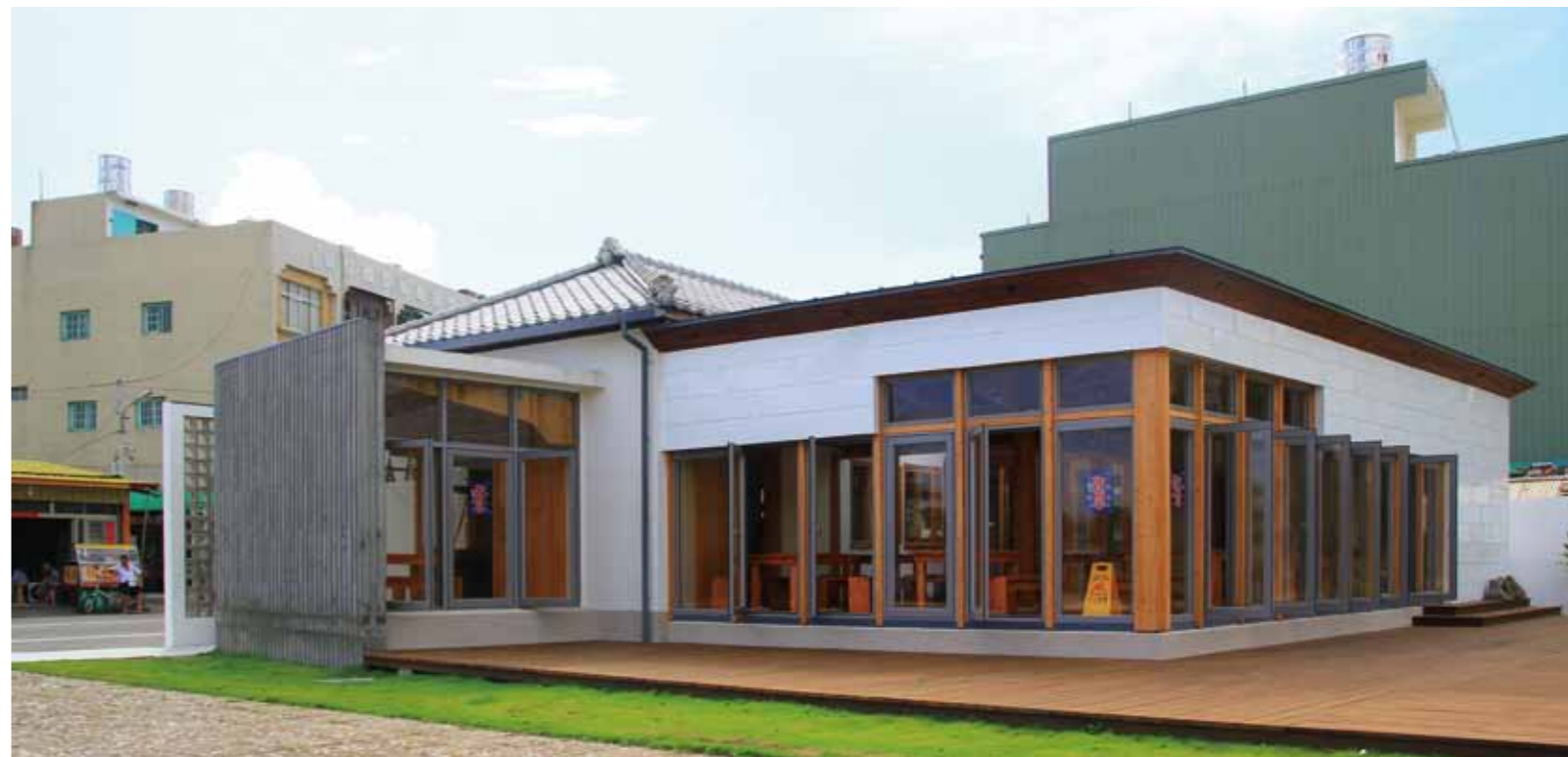
餐廳後棟設置雙面落地窗，引入廣場及錦鯉池等室外景觀，創造輕盈舒適之用餐空間。
