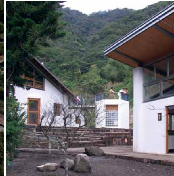
枕木平台連接班群教室與音樂教室
