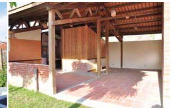
豬寮改建休憩茶庭兼廁所
