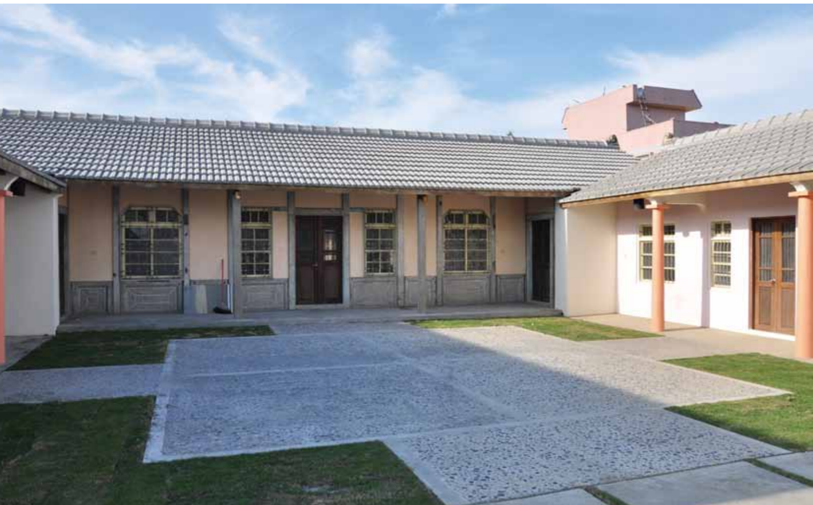
B、C棟外觀與廣場
