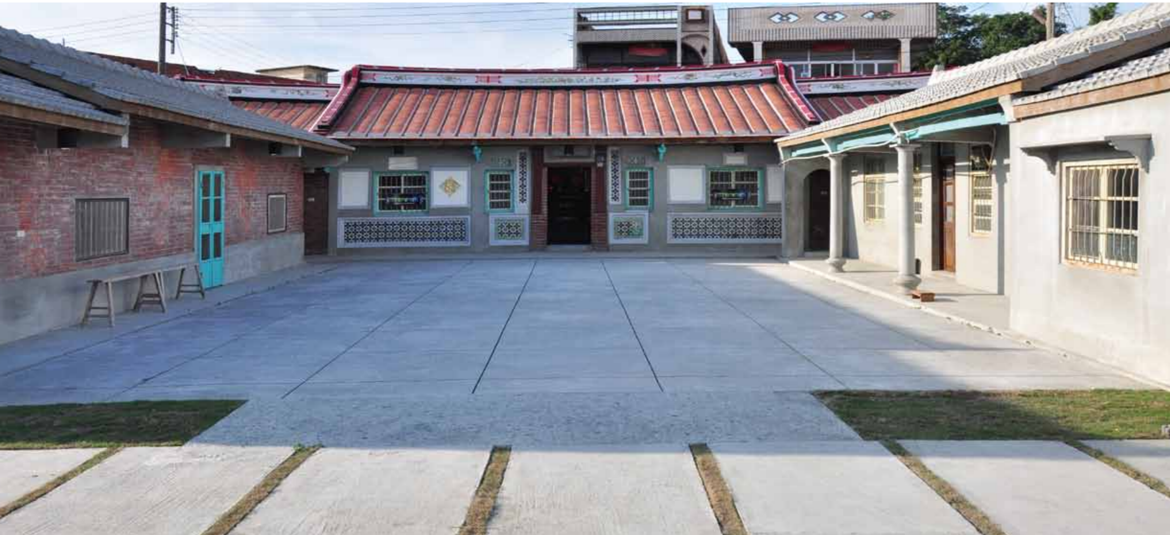
D、E、F棟外觀與廣場
